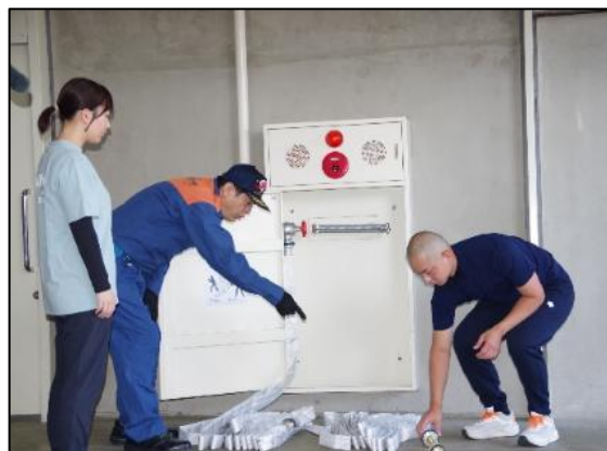
【訓練の様子（屋内消火栓設備）】
