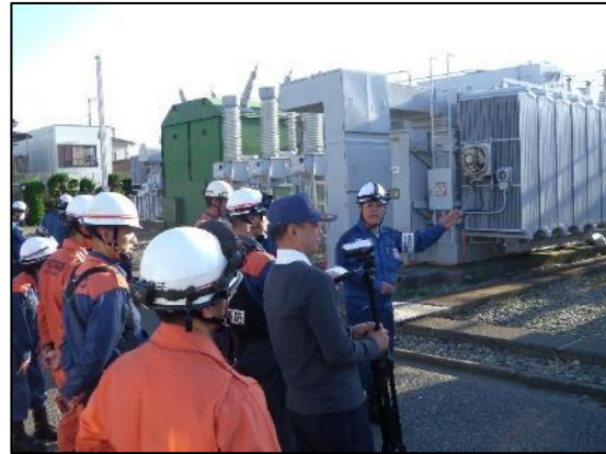
【変電設備の説明の様子】
